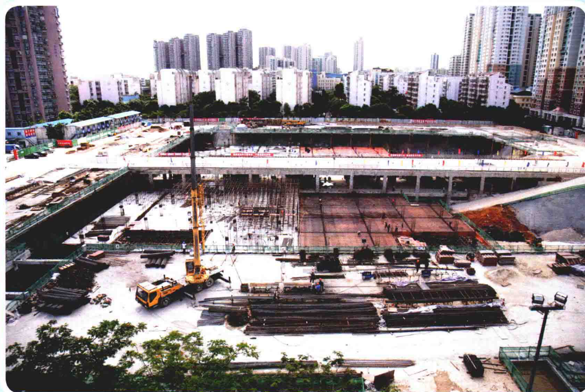
环板逆筑法支撑体系全景
