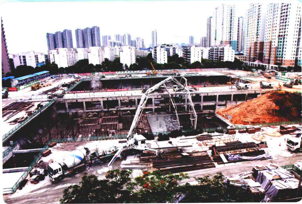
环板支护下的主体结构施工全景
