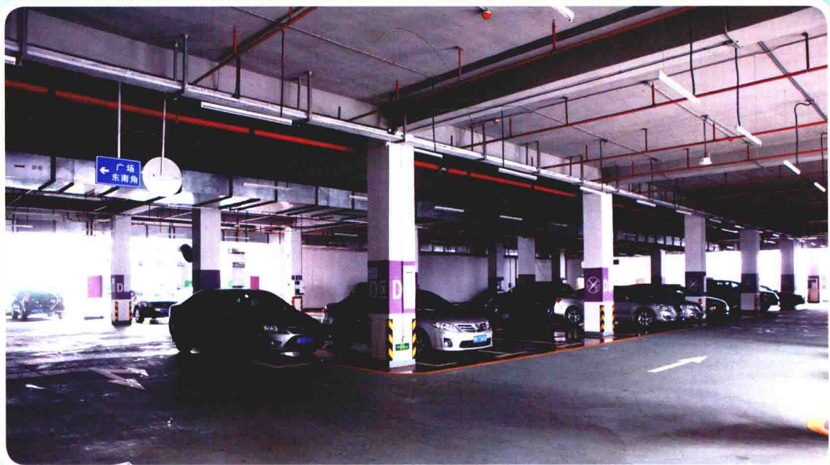
建成后的地下停车库
