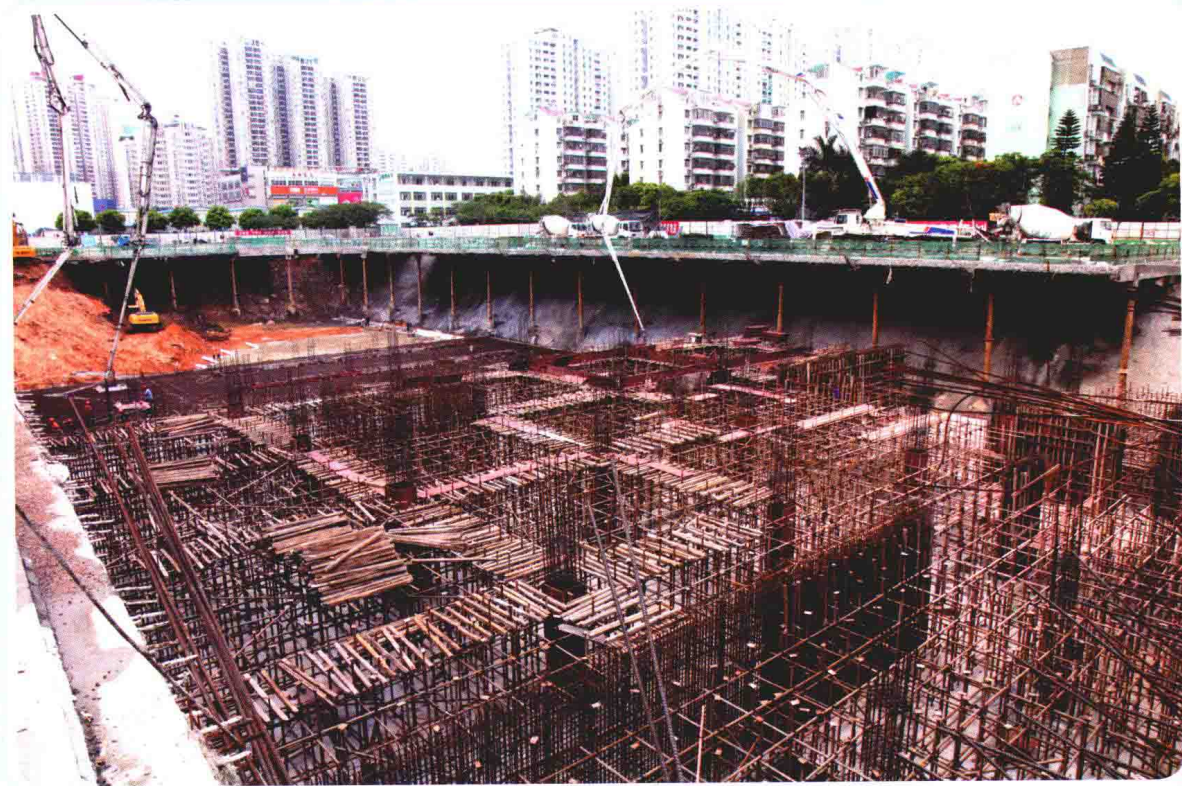
环板支护下的主体结构施工近景
