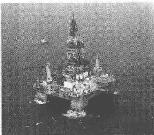
图 1-6 中国“海洋石油 981”深水半潜式钻井平台
