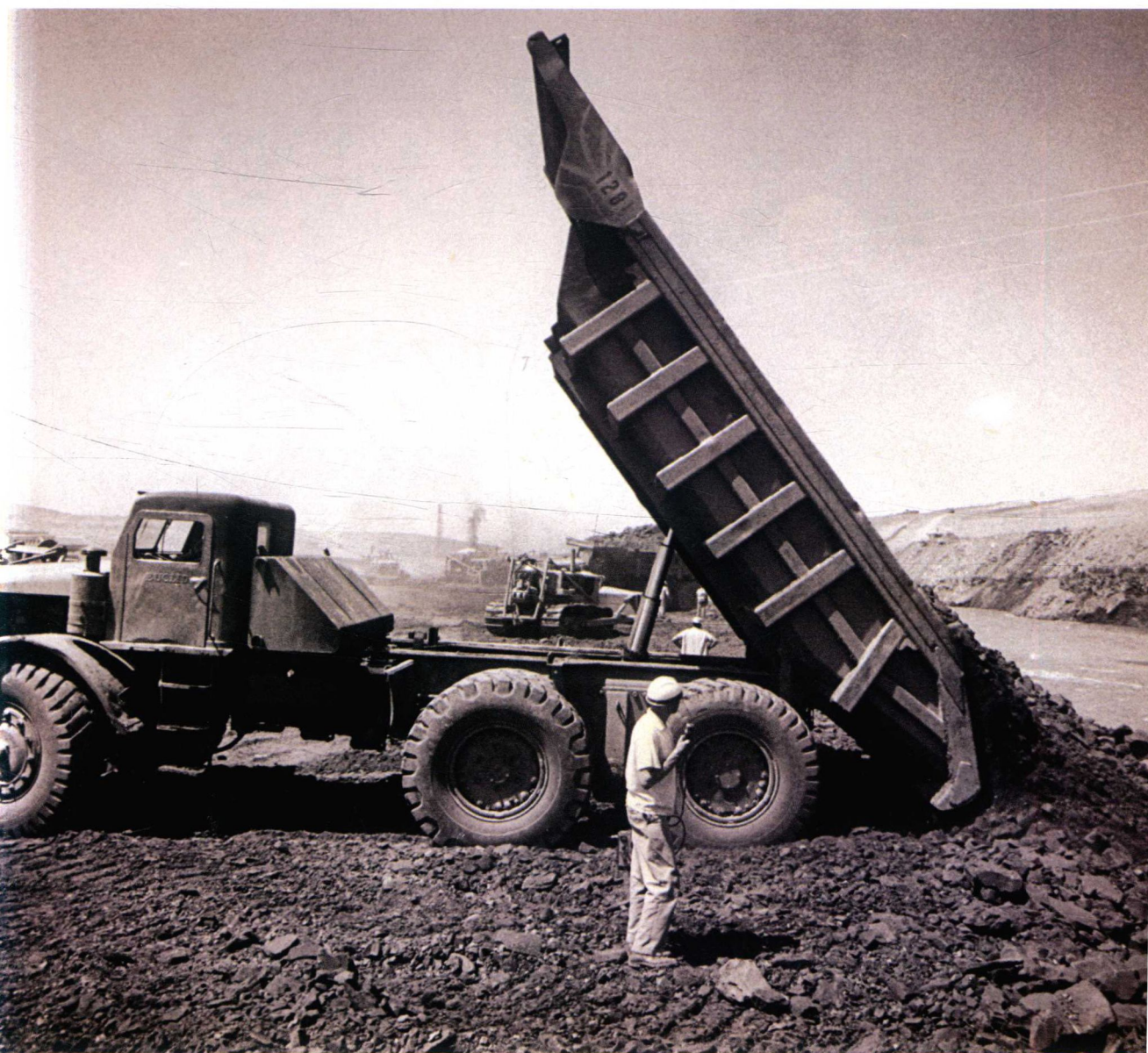
一辆自卸车正在往堤坝上倾倒土石料。
