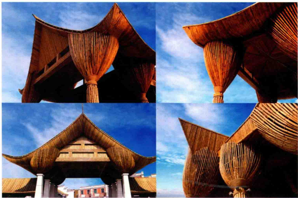
图3 陈皮村入口竹建筑结构
