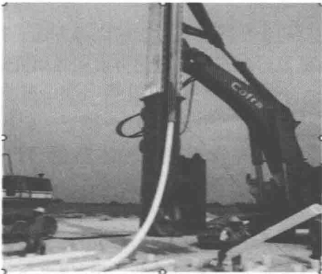
图 1-3 国外 AuGeo 桩施工
