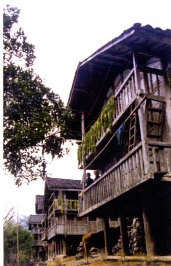
沿河鲤鱼池村吊脚楼
