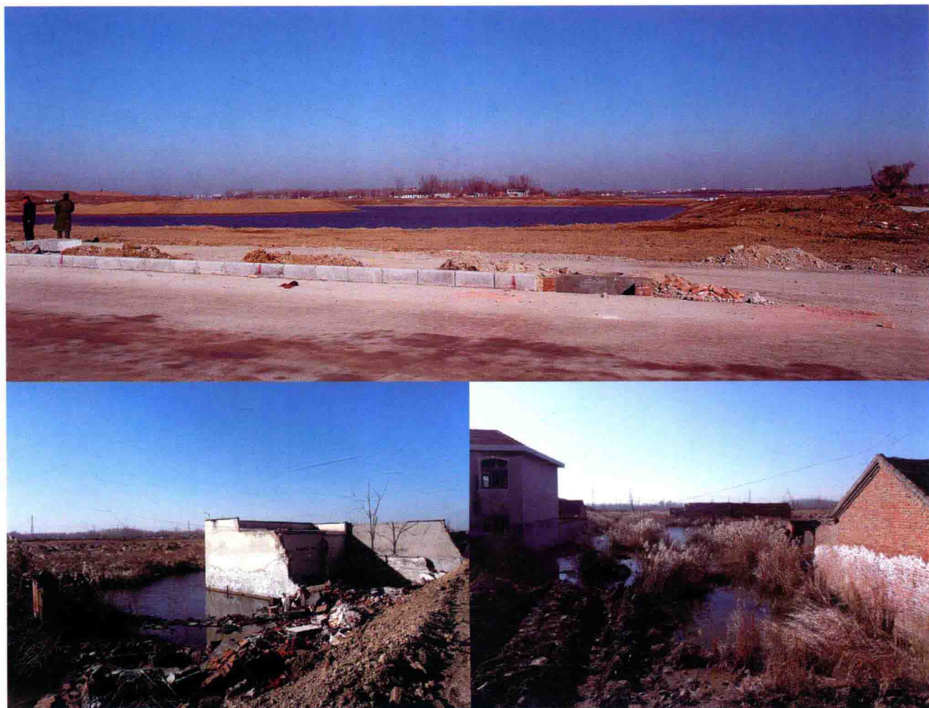
▲ 永城煤矿采矿塌陷区外貌
