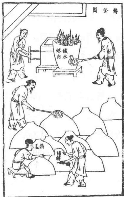
图 1—4 明代宋应星著《天工开物》中的铸釜图
