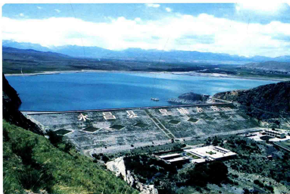
1985年8月，永昌县皇城水库竣工，水库总库容为8000万立方米，是集防洪、灌溉、发电、养殖为一体的大型水库。水库的建成运行，有效缓解了金昌市工农业生产用水突出的矛盾，是金昌市和金川公司地企合作的见证。
