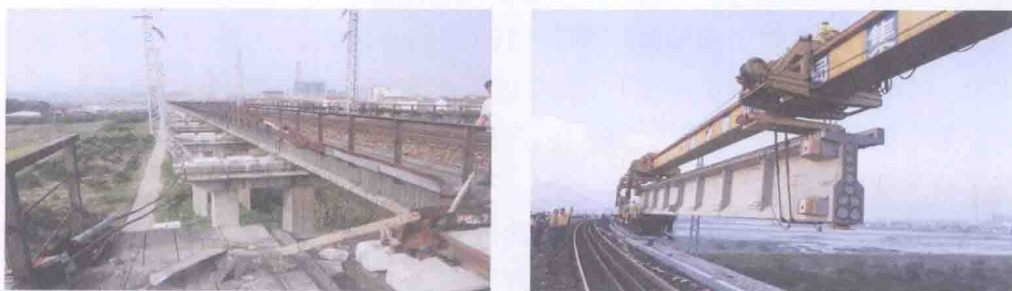
图 1-2 邻近既有线路架梁
