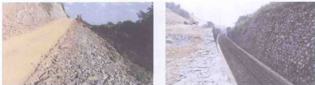
图 1-1 邻近既有线路基
