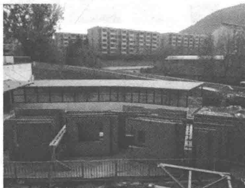
图 1.2-3 预制墙板插放实景图
