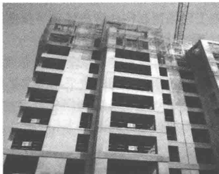
图 1.2-6 剪力墙结构施工实景
