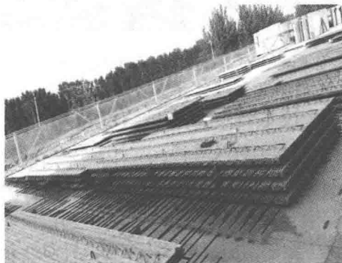
图 1.2-4 预制钢筋桁架板堆放
