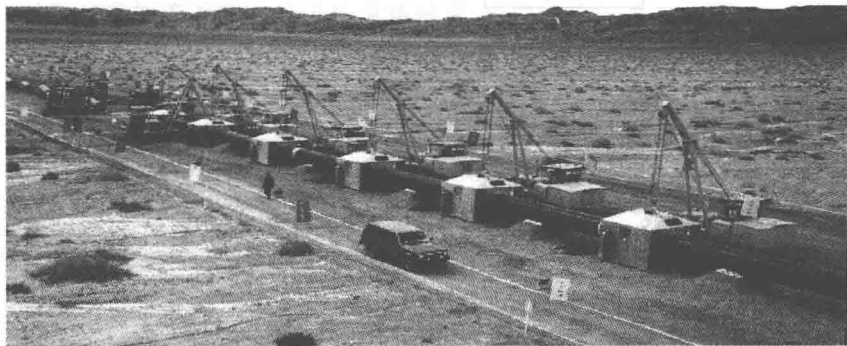
图 1-1 管道自动焊接机械化流水作业
