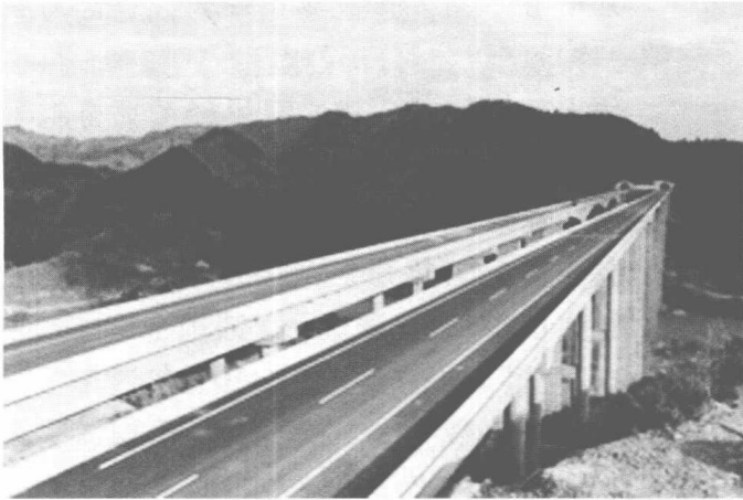
厦蓉高速都柳江一号特大桥，位于榕江县上都什寨旁，桥长800多米，最高桥墩有98米
