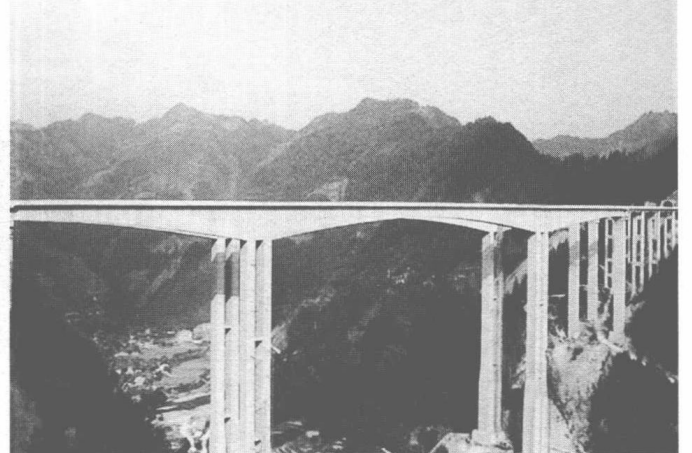
厦蓉高速排调河1号特大桥
