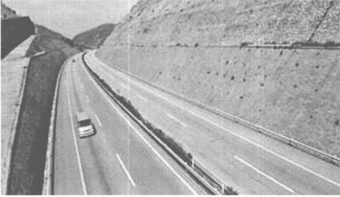
三凯高速公路小高山大拉槽
