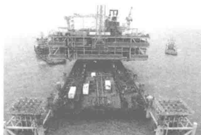
图 1.3 单船浮托安装法
