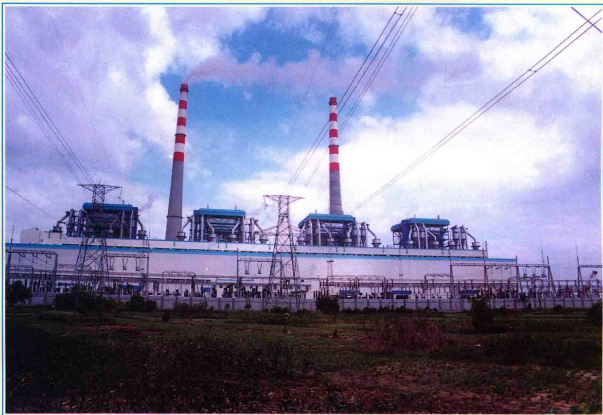
● 国家“九·五”重点工程——120万千瓦襄樊火电厂
