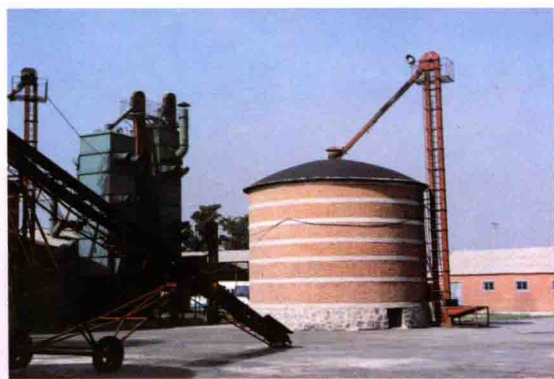
鞍山市第七粮库粮食烘干塔等设备
