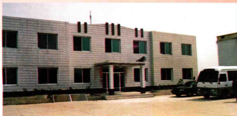
鞍山市第七粮库办公楼
