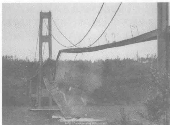
图 1.5 塔科马海峡大桥垮塌
