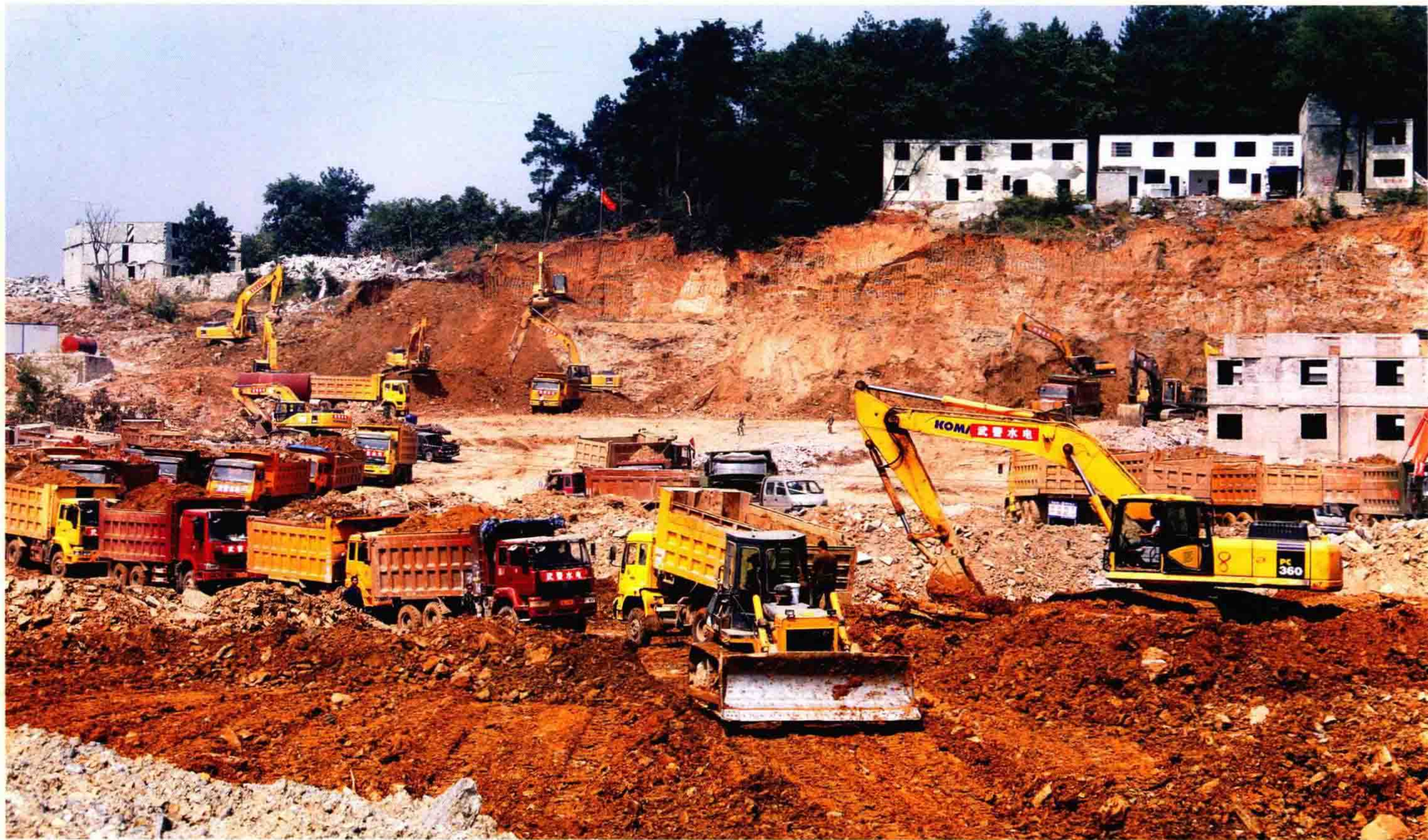
901项目拆迁平场施工现场
