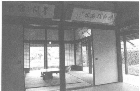
图1.3 日本传统的民居（大隈重信旧宅，佐贺市） 江户后期至明治初期的日本民居，大屋顶的隔热效果、回廊形成的过渡空间以及糊纸隔扇拉门、拉窗在拉开时都可以产生良好的通风效果。因为这些建筑中没有供暖、供冷设施，所以对周围环境的影响很小。但在冬季，居室内的室温就会很低。
