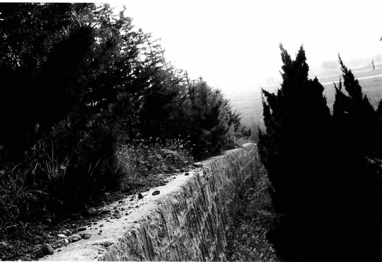
▲ 浆砌石挡墙客土绿化
