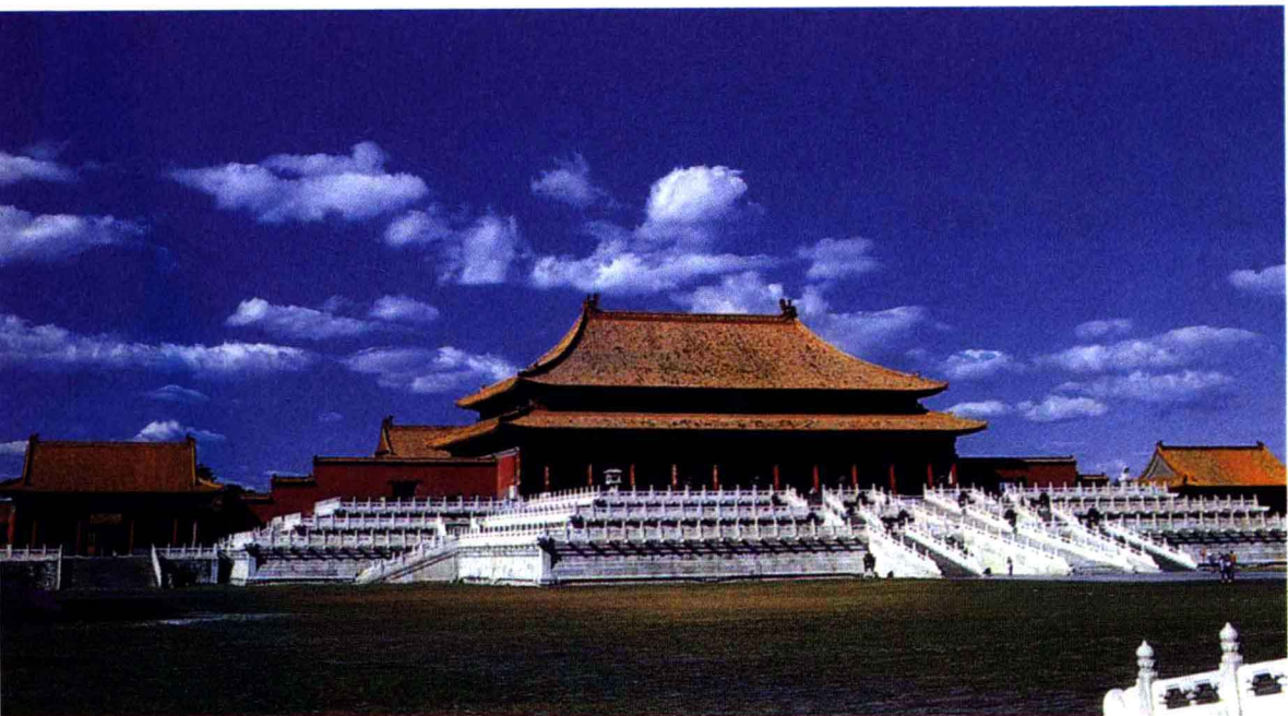
太和殿俗称“金銮殿”，是木结构建筑，采用重檐庑殿顶的模式，内部用圆木支撑，其规模和各种饰物的数量都是顶级的。
