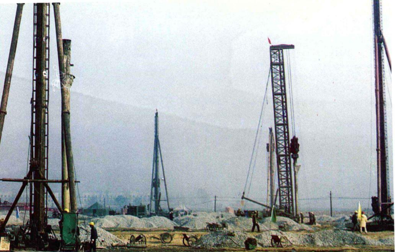
DK-60 型钻机在郑州东周水厂施工碎石桩
