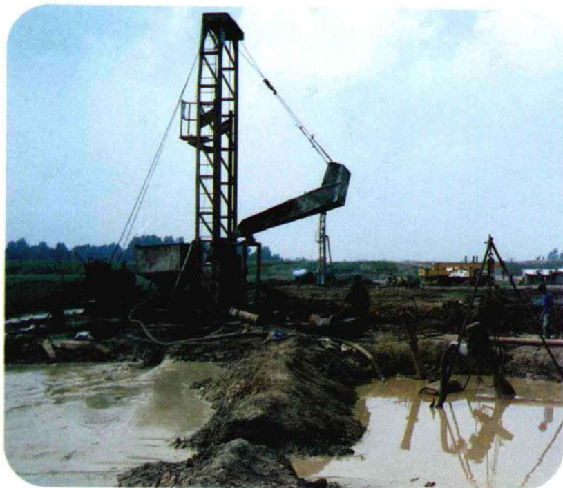
GPS-15 钻机在山东马兰桥施工灌注桩
