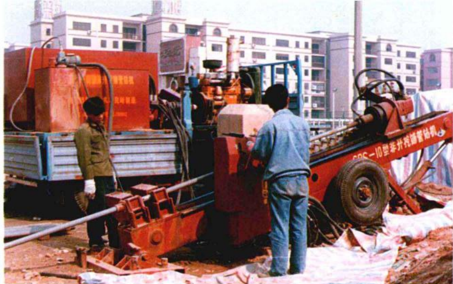
GBS-10 型非开挖 铺管钻机
