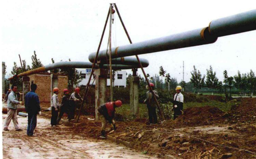
陕县热力管道对接安 装
