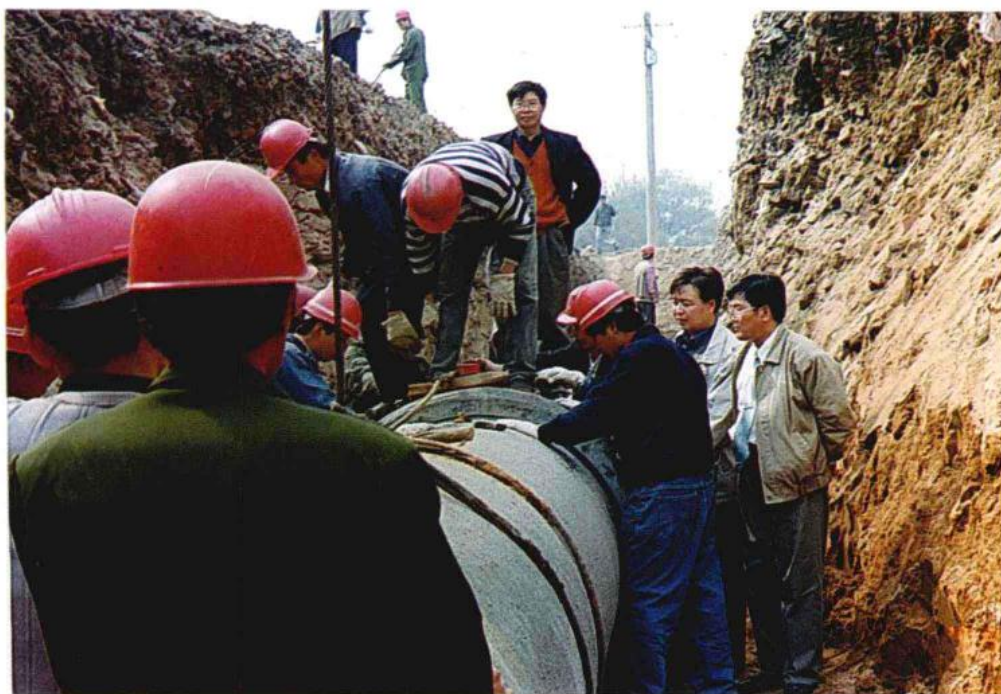
郑州市东周供水公司 配水管道安装现场
