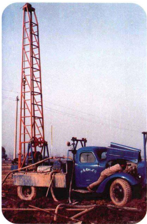
DDP-100 汽车钻勘察施工
