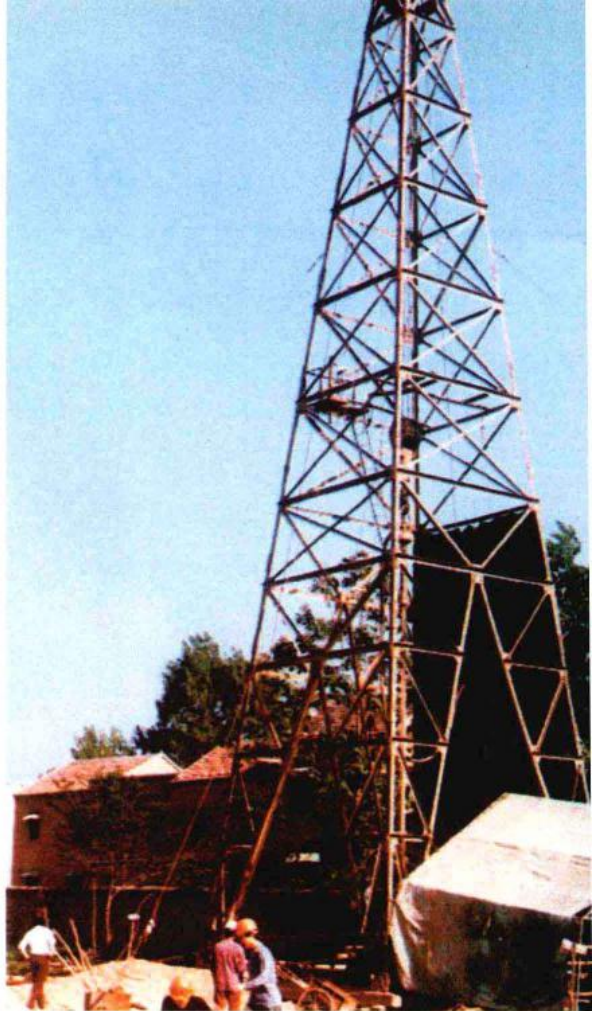
千米钻机在施工
