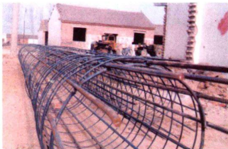
尉氏“8·13”项目桩基用钢筋笼
