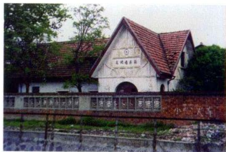
马回岭车站旧址。1927年7月底中共中央前敌军委书记聂荣臻赴此与张云逸、周士第部署四军二十五师起义事宜。
