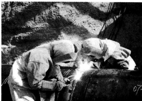
图 1-7 西气东输工程管道焊接
