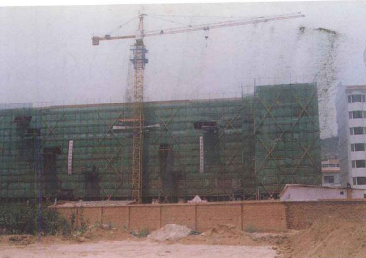
正在建设中的泽子沟村商业大楼
