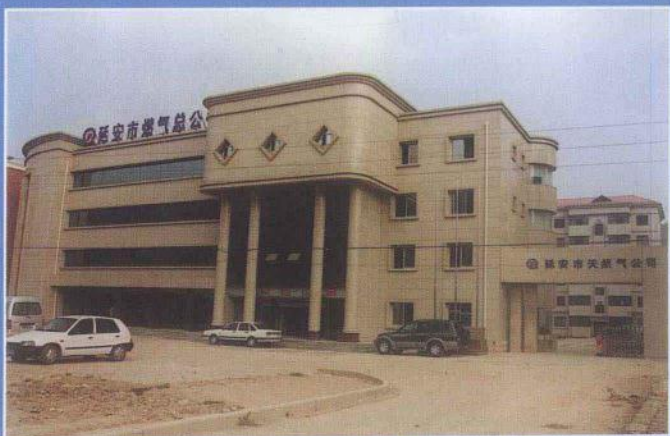
延安市燃气总公司
