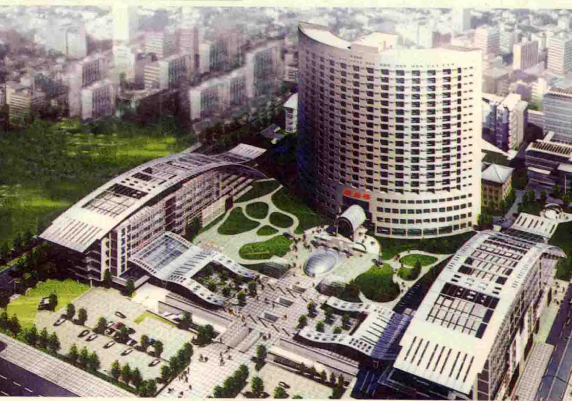
新病房大楼和建设中的 新门诊医技楼全景
