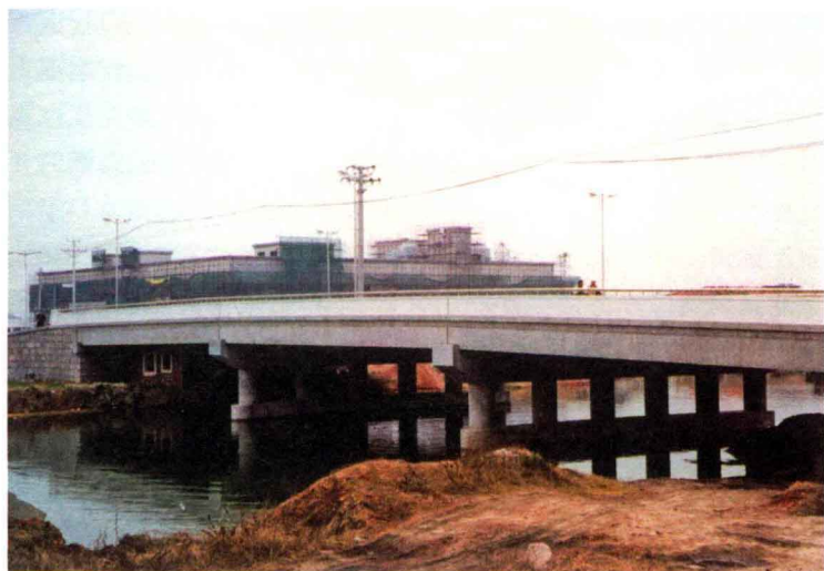
图1-14 瓜泾口河口上2005年建造的吴口市瓜泾桥
