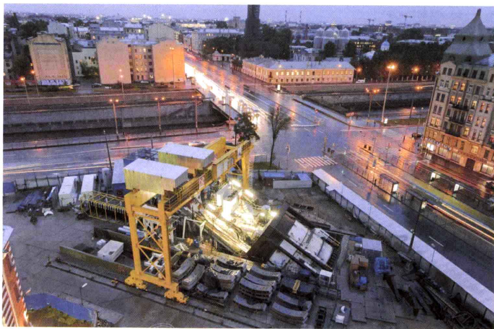
图 2-2 大坡度掘进机始发(夜景)
