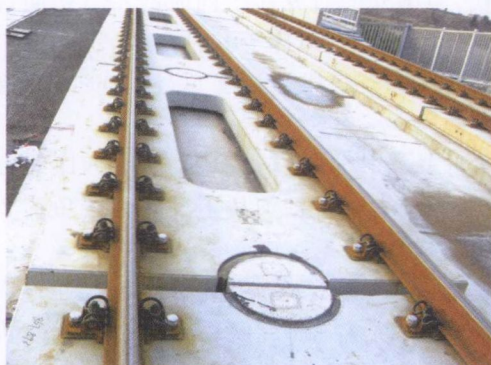
图 1—6 CRTS I 型板式无砟轨道
