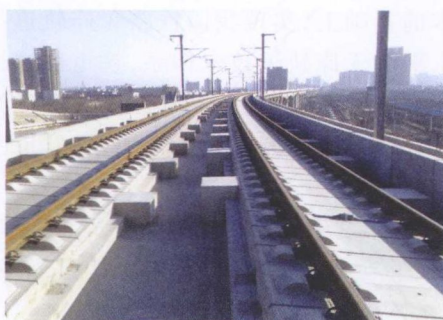
图 1—8 CRTS II 型板式无砟轨道
