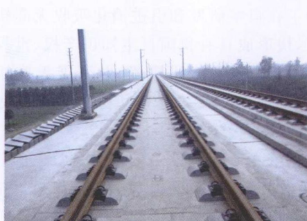
图 1—9 CRTS III 型板式无砟轨道
