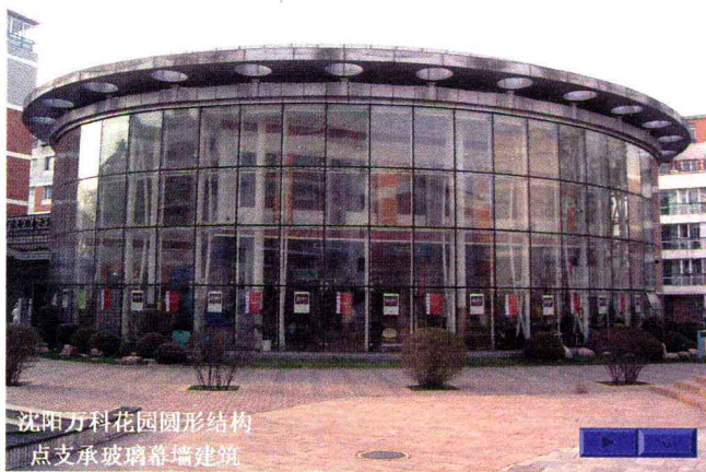
玻璃幕墙实例图片
