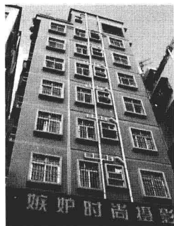
图 15 外露的管道
