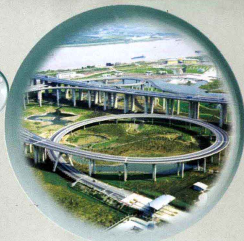
润扬大桥世业洲互通鸟瞰
