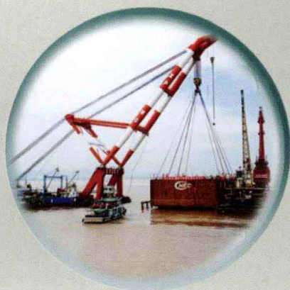
悬索桥北塔1000吨钢吊箱一次吊装
