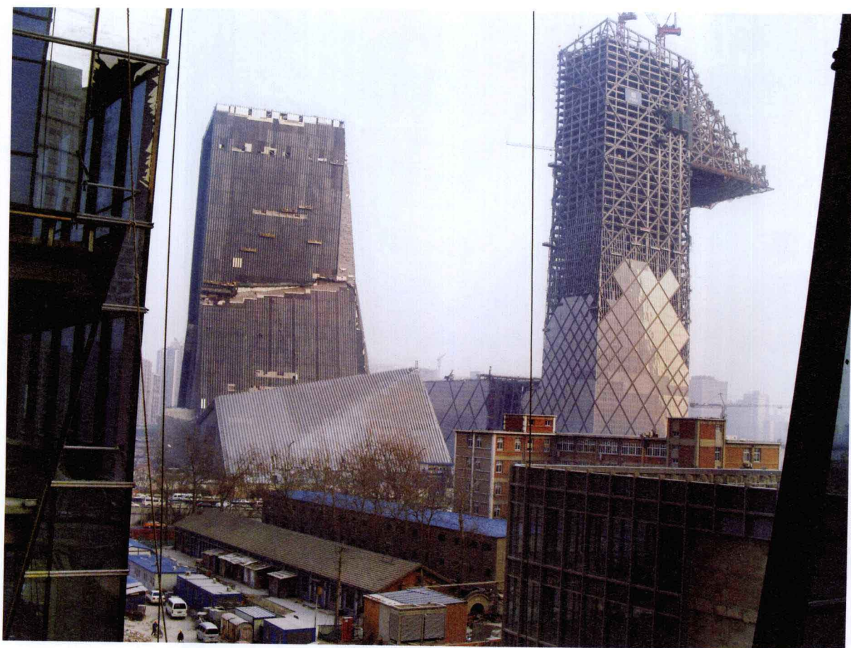
从财富大厦看建设中的 CCTV 大楼
