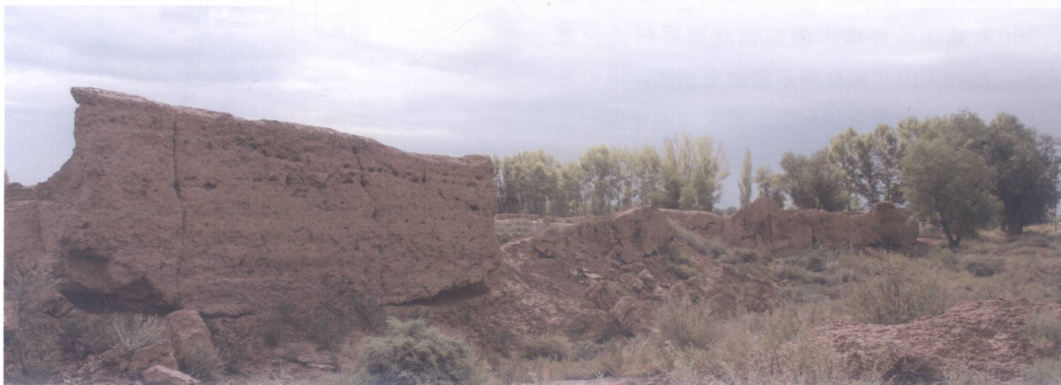
新渠古城西墙
