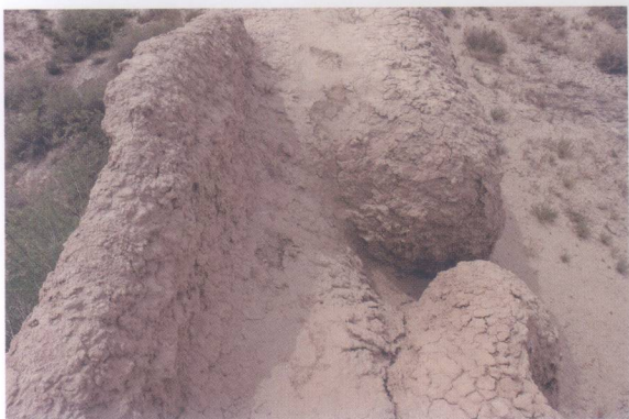
马桥城大城内南城墙上的女墙
