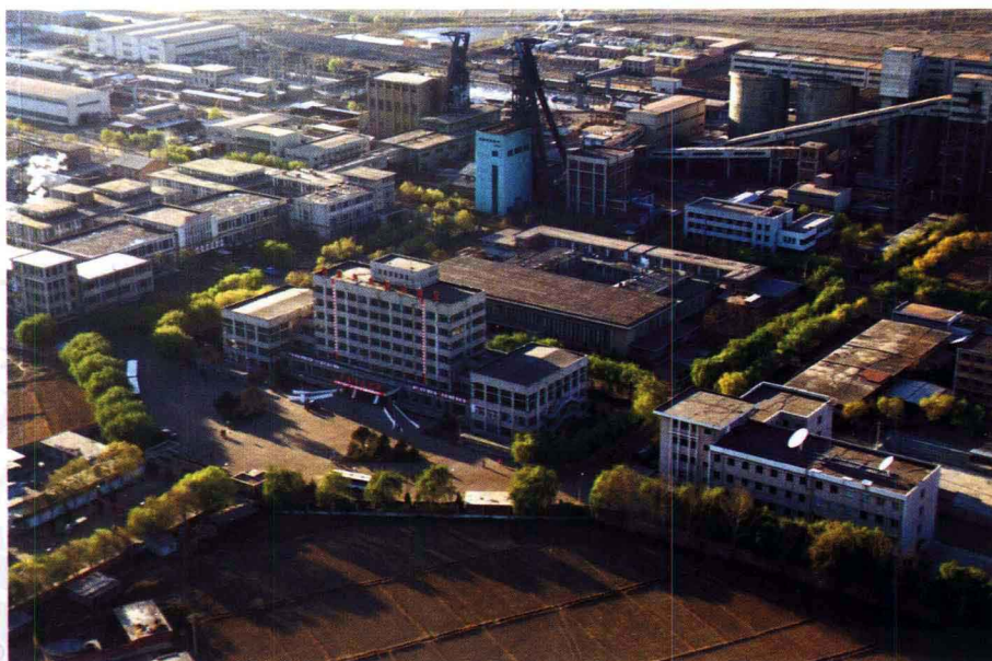
开滦钱家营矿业分公司工业园区
