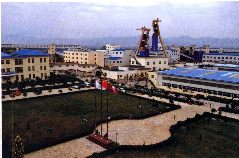
开滦蔚州矿业公司单侯矿工业园区
