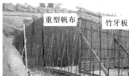
图4 洞口放炮防冲击及飞石防护
