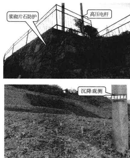
图6 高压电杆加固
