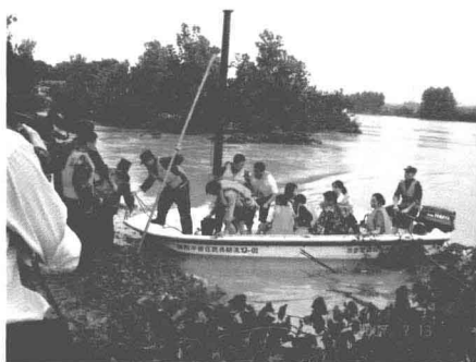
2005年汛期来龙圩区潢河堤防抢险情景
