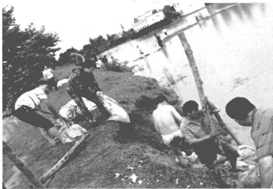
2005年汛期来龙圩区潢河堤防抢险情景
