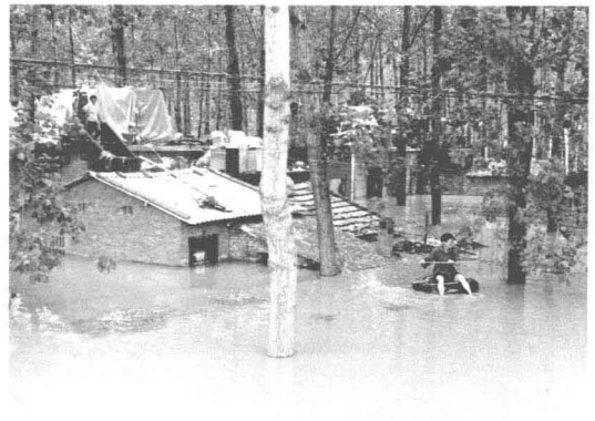
2003年汛期淮滨县王岗圩区内涝情况
