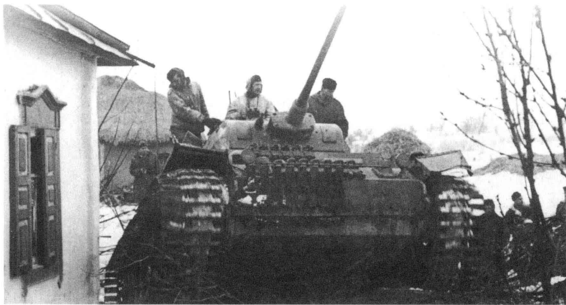
▲“帝国”师装备的Ⅲ号坦克J型。这种装备50毫米口径的L/60主炮在对付苏军装甲单位时已经显得相当吃力，1943年以后通常被德军当做轻型侦察车或指挥车使用。
