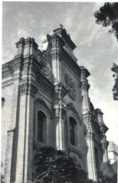
图19 北京宣武门天主堂正面局部
