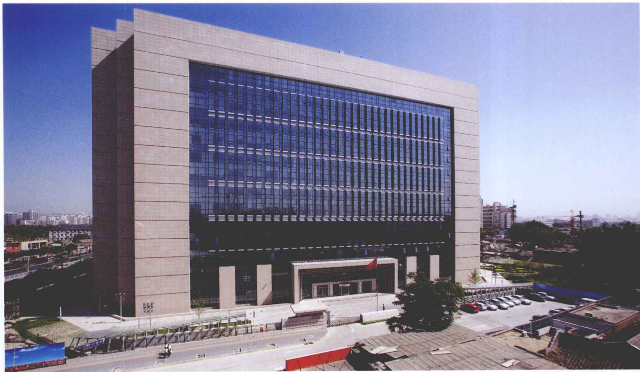
国家新闻出版总署办公楼外景
