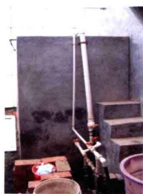
28. 温室内贮水池
