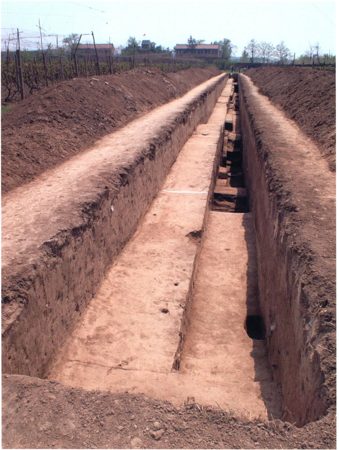
九 直城门大街遗址发掘现场
