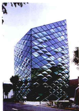
普拉达青山店(Prada Boutique Aoyama) 赫尔佐格·德·梅隆/竹中工务店/同0309期 通过采用隔震结构实现了建筑师想要的形象。在此建筑上，隔震不止是为了保障安全，也证实了能够扩展结构设计的自由度。（金箱温春）
