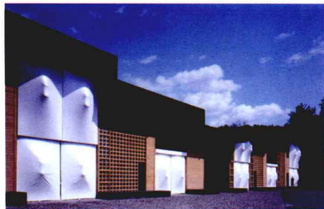
岐阜县立森林文化学院/北川原温/稻山正弘/日本《新建筑》0108期 使用木质格子耐力墙的建筑。复合材料如果说是以国外技术为基础的话,这个建筑就是把日本传统建筑进行了现代化的改进,开拓了新的领域。 (金箱温春)
