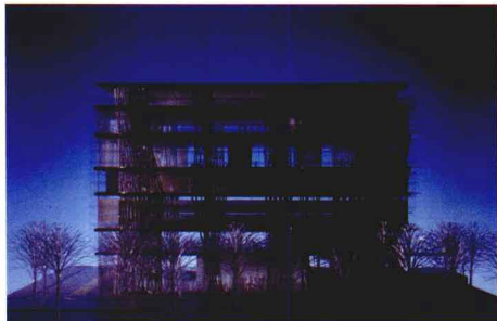
仙台媒体中心/伊东丰雄/佐佐木睦朗/日本《新建筑》0103期 扭弯曲的格子结构,使用了管子与超级薄的平板构成的综合设施。竞赛时的海草手绘和抽象的模型给人留下了深刻的印象,此建筑也因为采用了造船技术的焊接方法及与精度施工的斗争等原始性的现场工作成为话题。 (大野博史)
