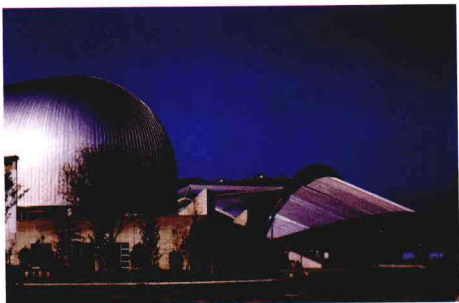
藤泽市秋叶台文化体育馆 / 横文彦 / 木村俊彦 / 日本《新建筑》8411期 主要材料为通过架起两根长达80m的弧形状屋脊，来支撑屋顶和观席。不以屋顶面整体为主，利用大梁的结构形式，充分地体现了时时注重施工方法的木村俊彦的设计手法。 (佐藤淳)
