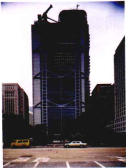
香港上海银行·香港总店楼 / 诺曼·福斯特 / 奥雅纳 / 日本《a+u》8606期 被称为高技术建筑系列的代表作。高层建筑的底部为开放式，巨型柱下垂的大胆方法构筑空间。实现这种结构的构件成为了建筑设计的主要表现方法。 (金箱温春)
