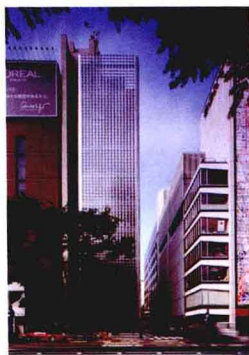
爱马仕大厦 Maison Hermès/伦佐·皮亚诺/奥雅纳 日本《新建筑》0309期 为了实现玻璃板的表面，架构的宽度受到了限制，地震时会发生浮起现象，但建筑师反而利用了这一性质安装了制震装备，实现了结构的合理性和对于表面的追求。（金箱温春）
