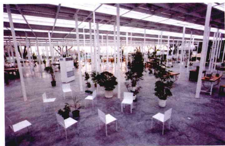
神奈川工科大学KAIT工房/石上纯也/小西泰孝/同0803 以往很多结构纤细的建筑物需要在某些地方设置抗震构件,此建筑因为采用了平钢,也实现了有效抗震。所以采用了预应力施工方法。(金箱温春)
