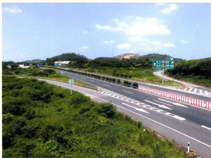
惠来高速公路出入口处
