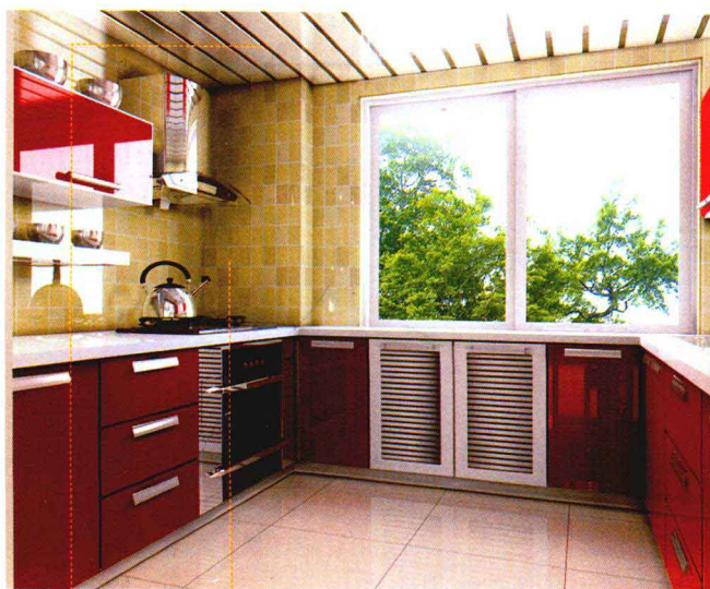
铝扣板吊顶 通体砖墙面
