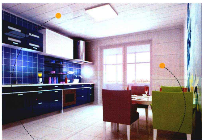
铝扣板吊顶 釉面砖墙面
