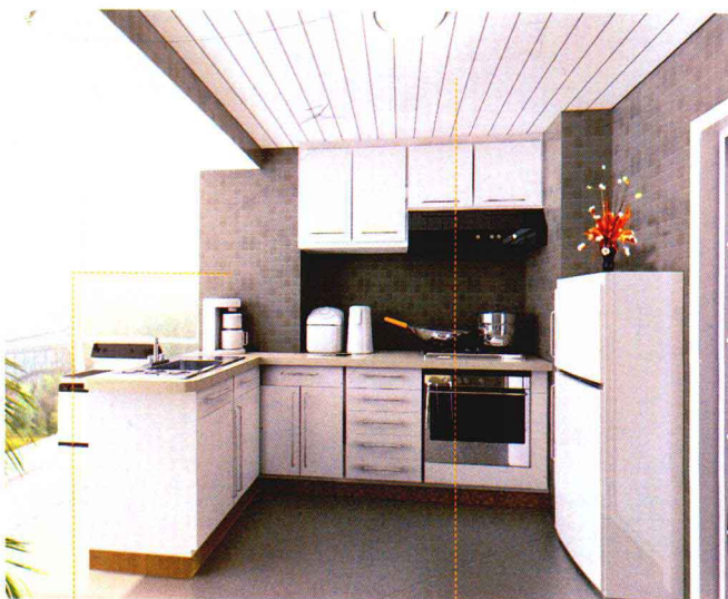
通体砖墙面 铝扣板吊顶
