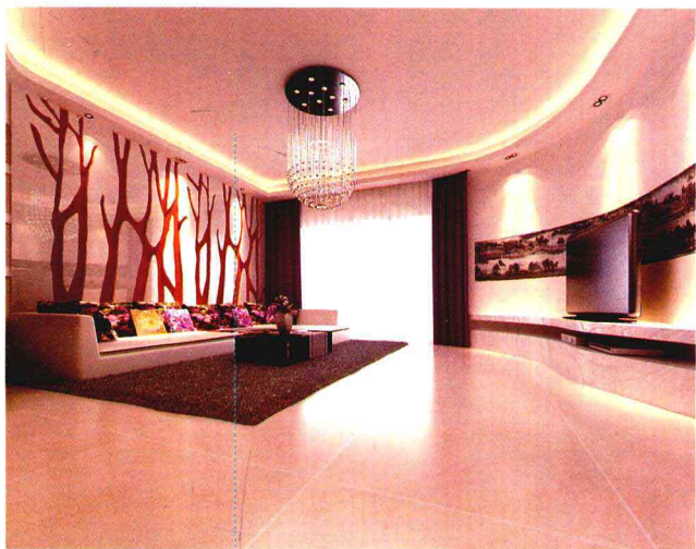
石膏板局部吊顶
