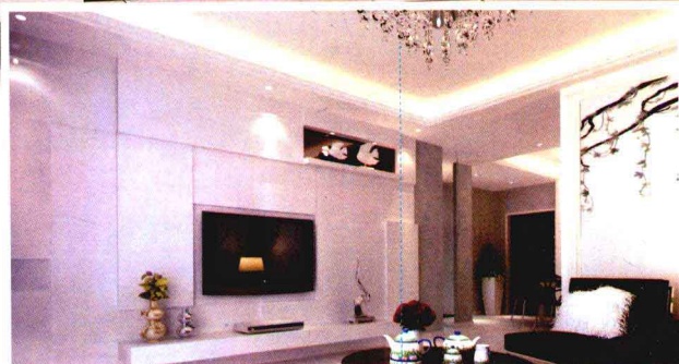
石膏板局部吊顶
