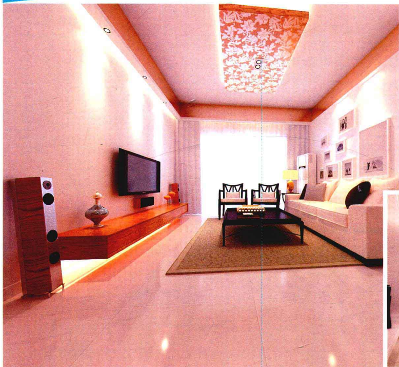
木板+PVC壁纸悬吊顶
