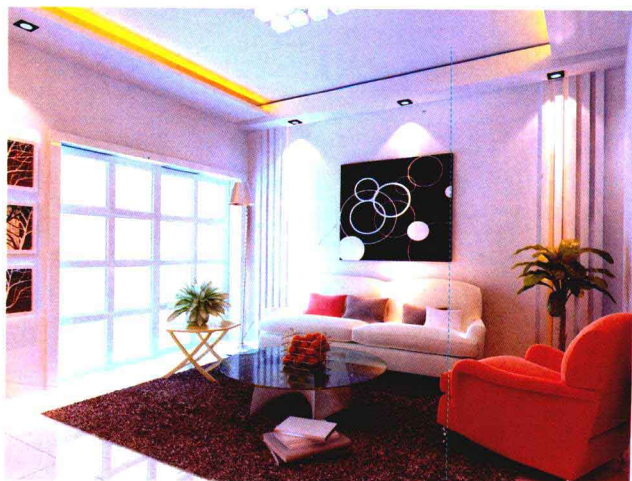
石膏板局部吊顶+暗藏式灯带
