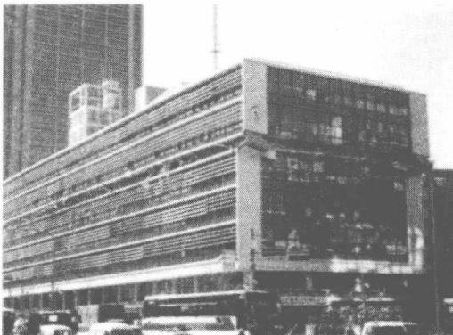
图 1-9 构件强度不足使局部层破坏
