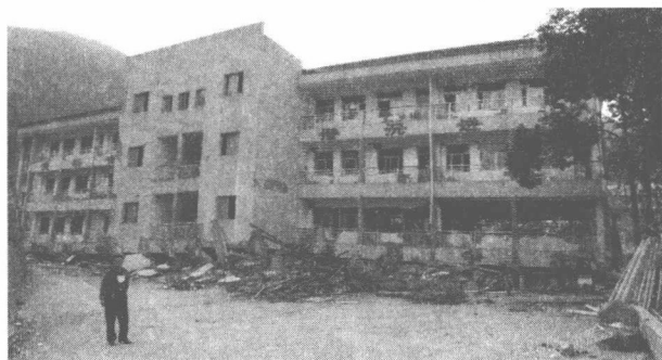
图 1-12 由于地基失效北川中学五层教学楼仅剩三层
