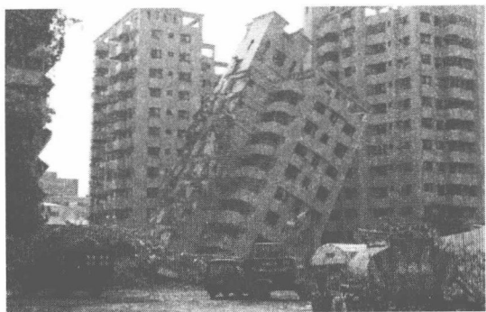
图 1-10 汶川地震中房屋倒塌
