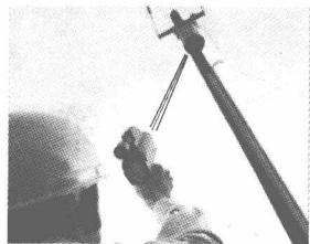
图 1-2 利用红外线辐射成像仪测量供电变压器的表面温度
