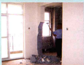
拆除墙体有一定的技术性,一般先拆下部、边侧,再向上、向内延伸。
