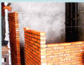
重新砌筑墙体要放线定位,放置至斜,厨房与卫生间地面还要注意防水。
