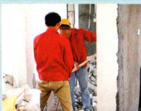
大块墙体砖块要装袋搬运至指定部位,细碎残渣可以留做卫生间填补地平。
