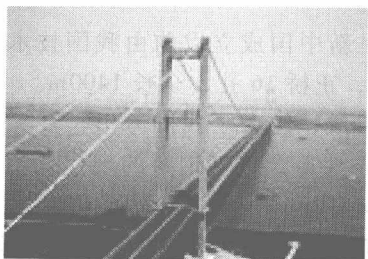
图 1-3 润扬长江大桥（悬索桥）
